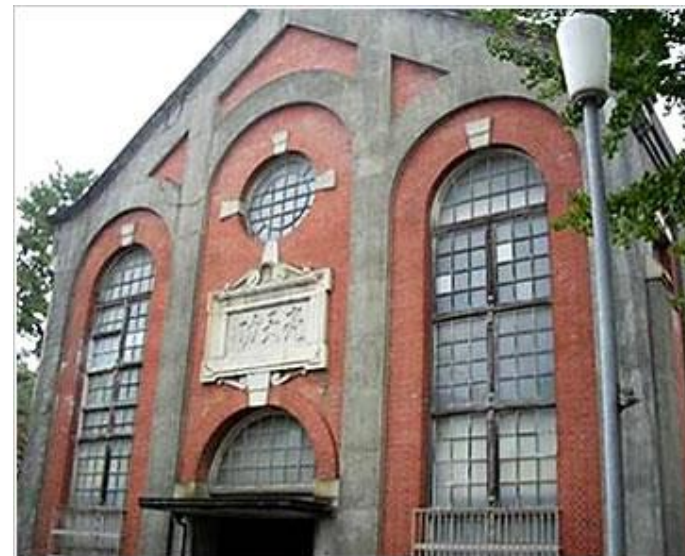
写真2 第2期発電所 書<功天亮>を望む
